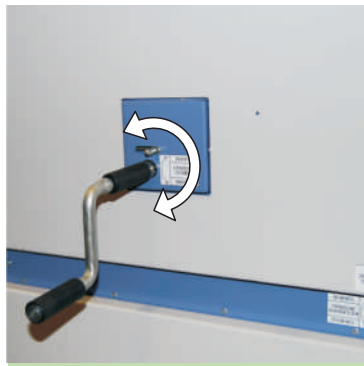
Управление выкатным элементом
