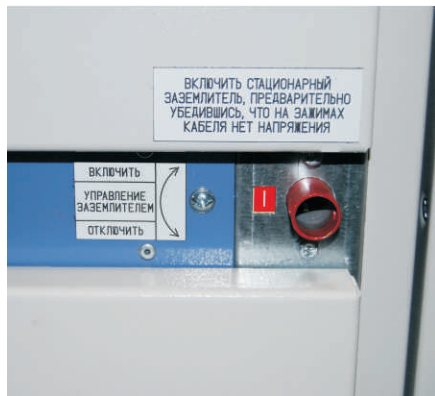
Механическая индикация положения стационарного заземлителя
