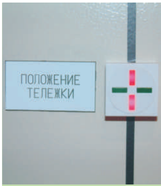
Электронная индикация положения выкатного элемента
