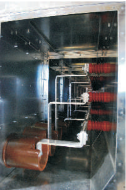
Магистральные шины без специальных изолирующих перегородок
