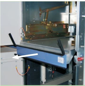
Демонтирование перегородки между отсеком выкатного выключателя и отсеком кабелей
