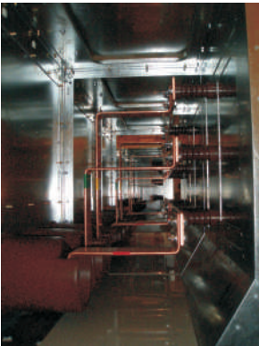
Магистральные шины без специальных изолирующих перегородок
