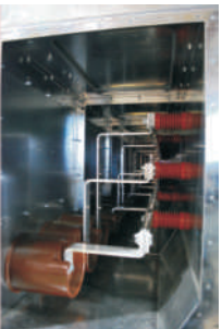
Съемный щит для доступа к магистральным шинам
