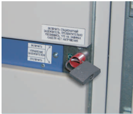
Запирание механизма стационарного заземлителя
