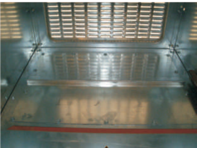
Съемный щит для доступа к магистральным шинам
