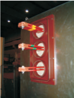
Магистральные шины со специальными изолирующими перегородками
